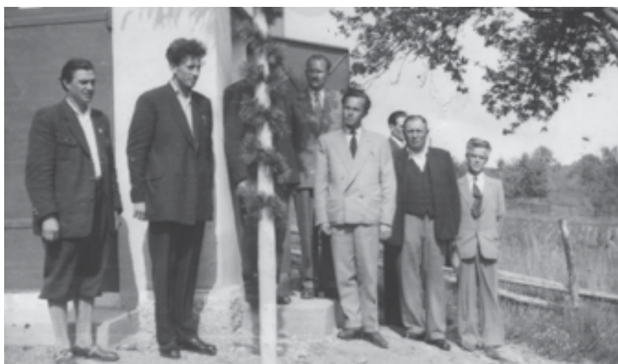
Izgradnja elektro trafo postaje leta 1956.
