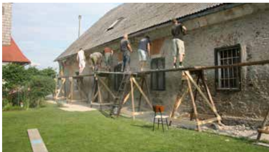
Obnova Oničeve hiše.
