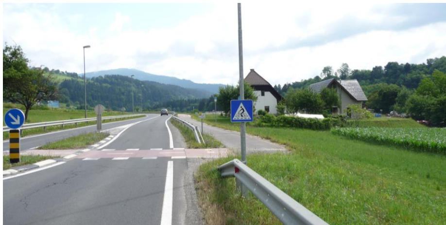
Slika 12: Pogled na glavno cesto G1-1/0241 Dravograd - Radlje – konec odseka predvidene kolesarske poti, na sliki desno z priključitvijo na obstoječo kolesarsko stezo
